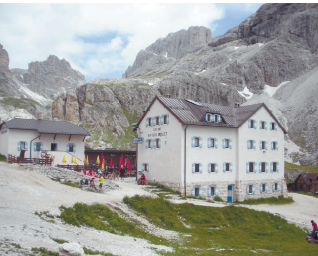
I rifugi del Catinaccio al centro dell'attenzione dei futuri ingegneri
