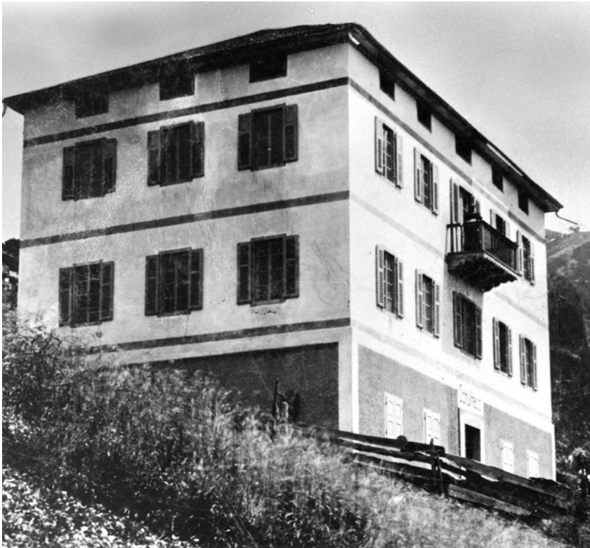
L'edificio scolastico di Palù in una foto di inizio Novecento. Sull'entrata la scritta "Schulhaus". (Foto: Antonio Oberosler, Archivio BKI)
