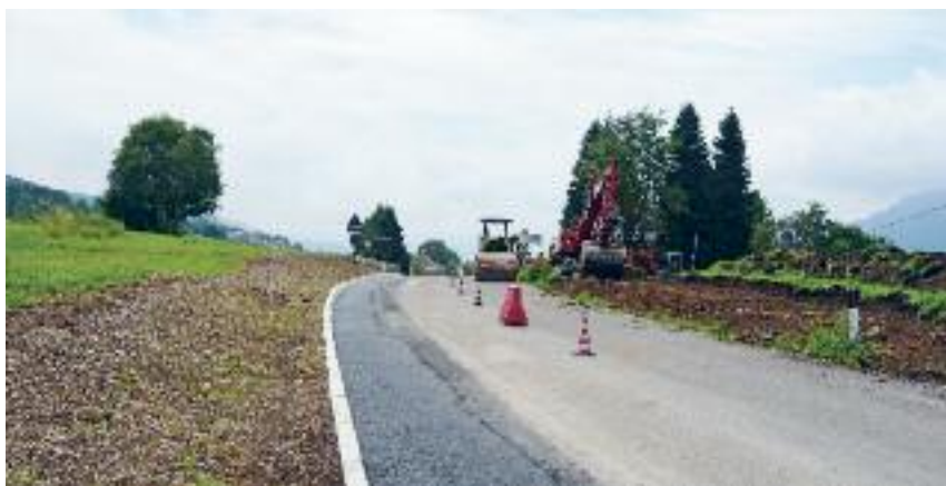
Lavori per pista ciclopedonale degli Altipiani Cimbri veneto - trentini in zona Kraüt Luserna
